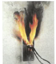
▲トラッキング現象により出火した電源プラグ
